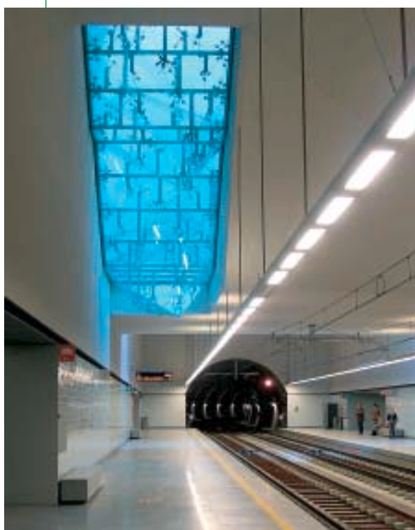
▼ Estación Salgueiros en Pontevedra.
